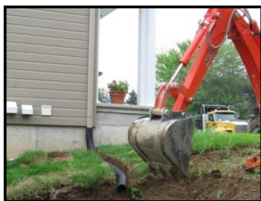
Jardin de pluie en construction
