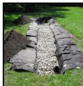
Tranchée d'infiltration en construction
