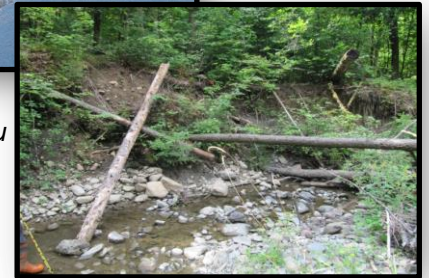
Érosion des berges du ruisseau
