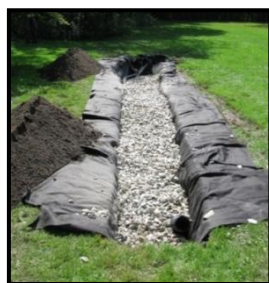
Tranchée d'infiltration en construction
