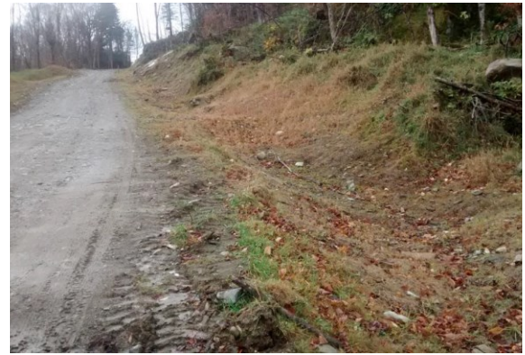
Chemin forestier aménagé dans une pente de 18 % en utilisant les techniques adéquates de contrôle de l'érosion. Le seul coût d'entretien à prévoir est le débroussaillage des fossés dans quelques années.
