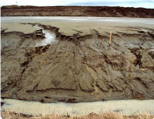
Photo 1 : Érosion d'un sol n'ayant pas été protégé lors de travaux
