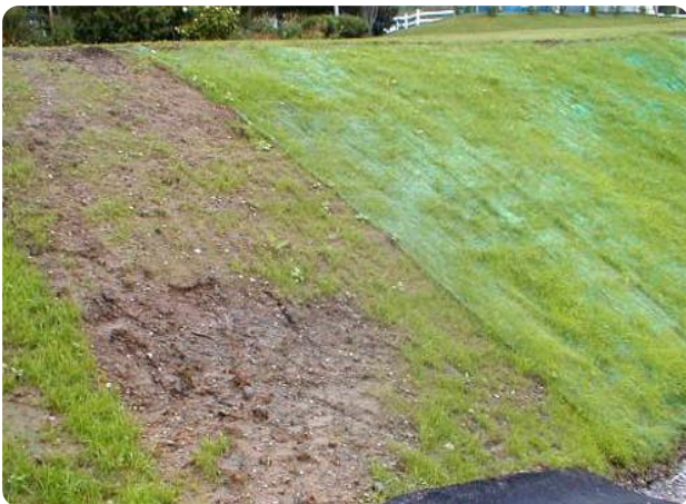
Photo 2 : Différence après ensemencement : sans protection (gauche) et matelas anti-érosion (droite)
