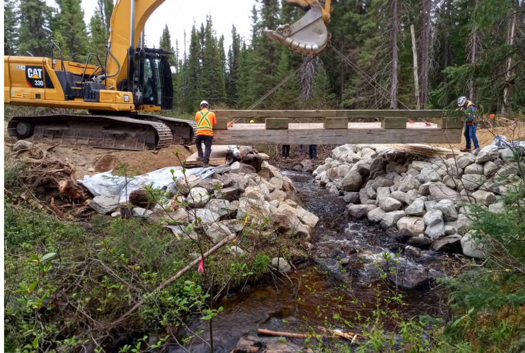
Figure 33 : Pose d'un élément de tablier préfabriqué (Ferland, 2022).
