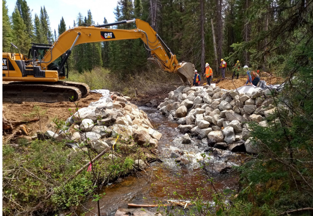
Figure 32: Appui constitué d'un remblai de nivellement (Ferland, 2022).
