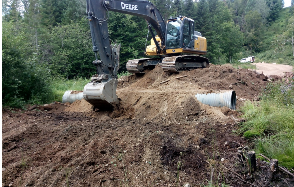
Figure 49: Retrait du matériel de remblai et des matières résiduelles d'un ponceau (Ferland, 2022).
